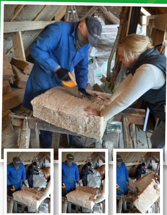
Eine **Fuchsschwanz Handsäge** ist vermutlich die unkomplizierteste Methode zum Schneiden
